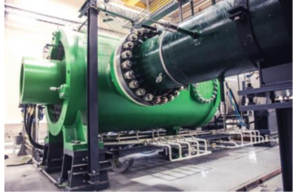
Abbildung 54: Neuer Elektroverdichter in der TAG GmbH Grafendorf (von KNEP 2019 – 2018; Titelbild)
